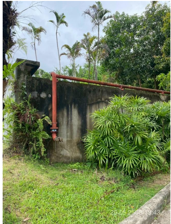
ภาพที่ 19 แสดงบ่อเก็บน้ำสำรองสำหรับดับเพลิง และห้วจ่ายน้ำดับเพลิง
