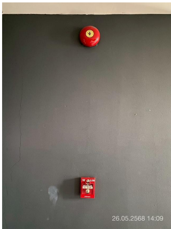
ภาพที่ 28 แสดง Fire Alarm และสัญญาณเตือนภัยด้วยมือ
