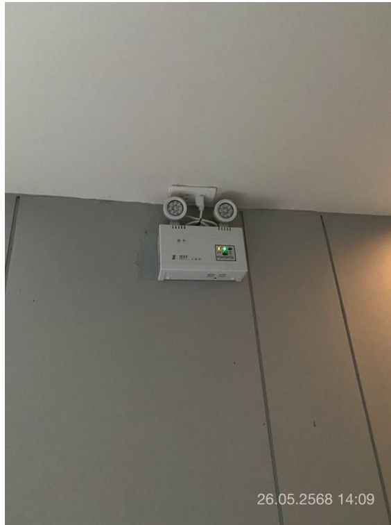
ภาพที่ 9 แสดงไฟส่องสว่างฉุกเฉิน
