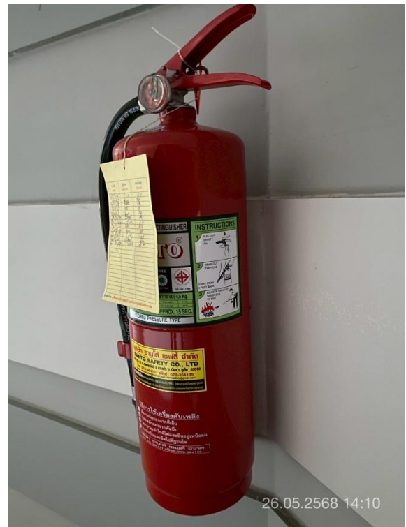
ภาพที่ 18 แสดงถังดับเพลิงชนิดผงเคมีแห้ง
